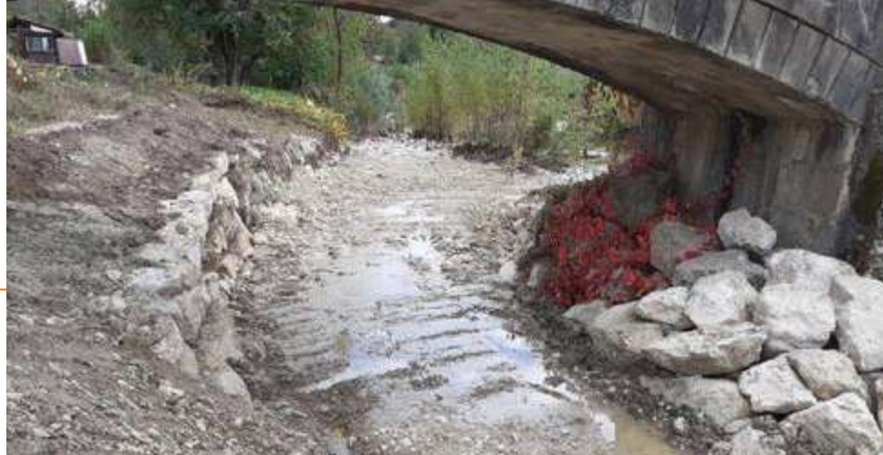
Pont du camping à Artemare - Création d'un seuil de fond et mise en place d'enrochements / 42 000 €
